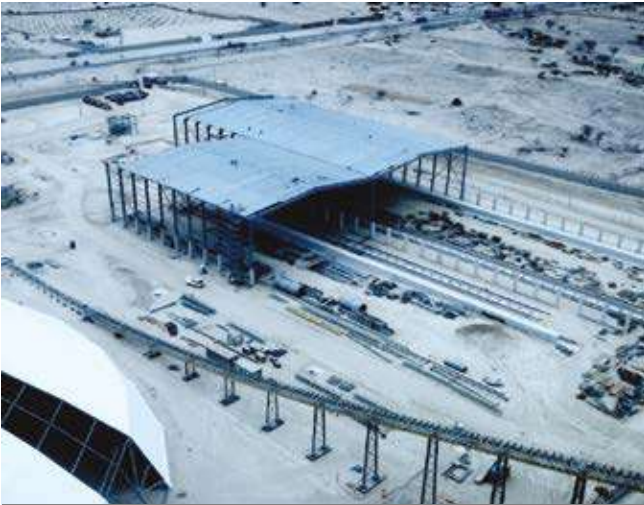
Planta Cementos Pacasmayo-Piura
